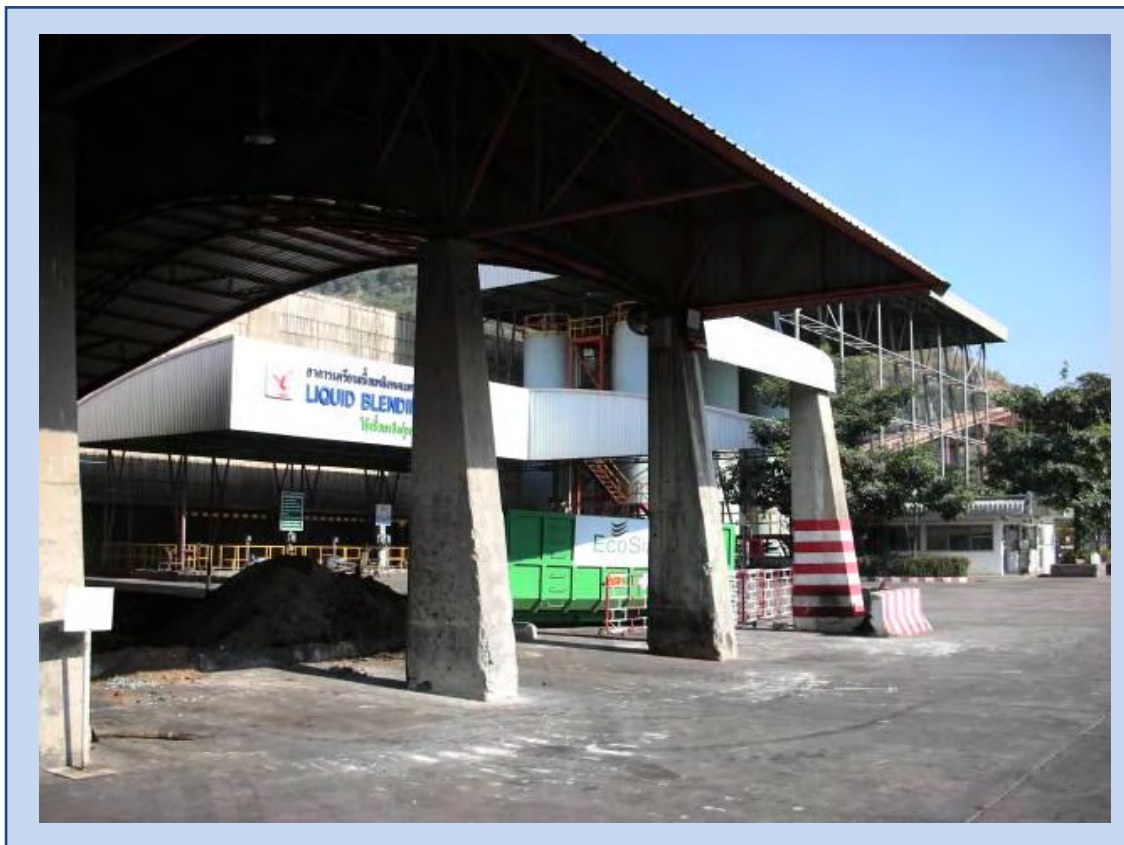
Figure 5: Hall de stockage et de préparation pour combustibles de remplacement (Liquid Blending Plant) [Photo : WhiteLabel]
